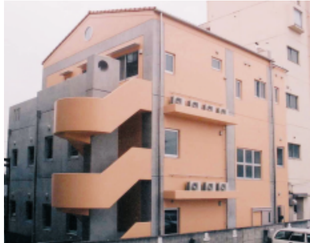
今回の工事 増築部分
