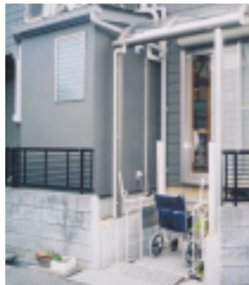
東側に設けられたトイレとなり昇降装置
